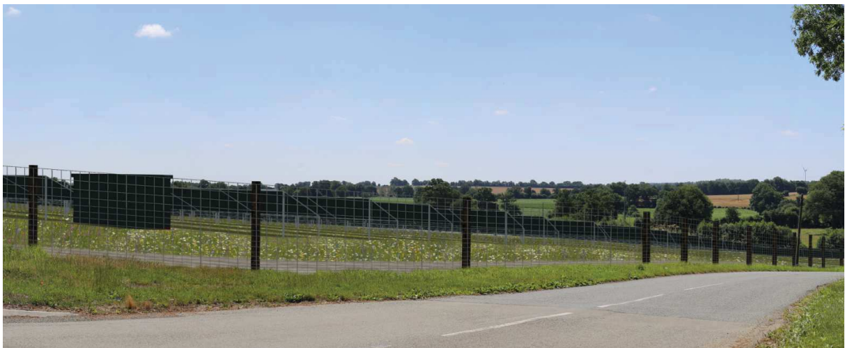
Exemple d'une clôture de parc solaire
