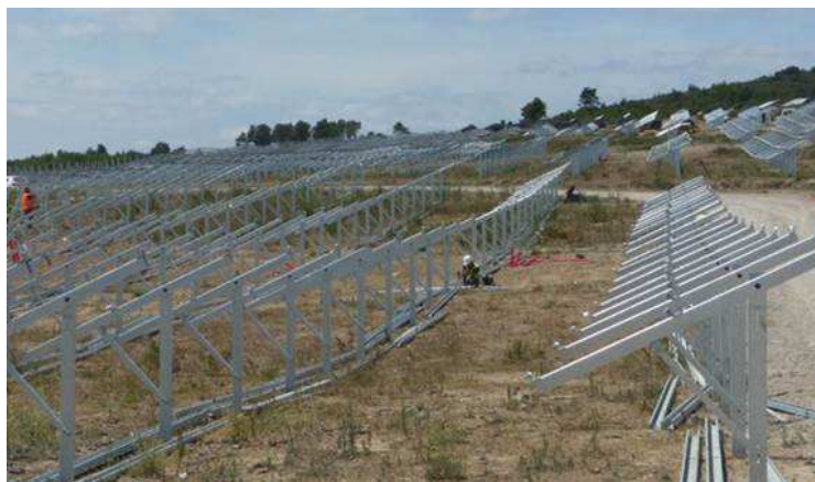
Photos : Exemple de pieux creux (source : QUADRAN)
